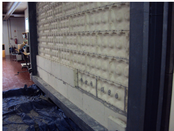
Fig. 3: Uma parede divisória eco-eficiente An eco-efficient infill wall.
