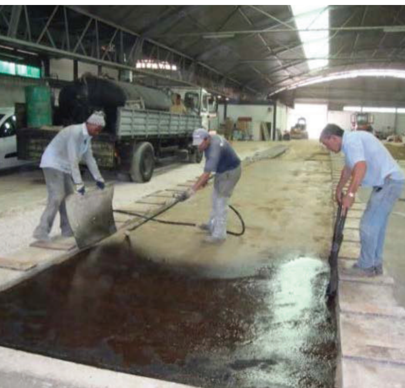
Figura 1:Aplicação da camada de desgaste no trecho experimental
